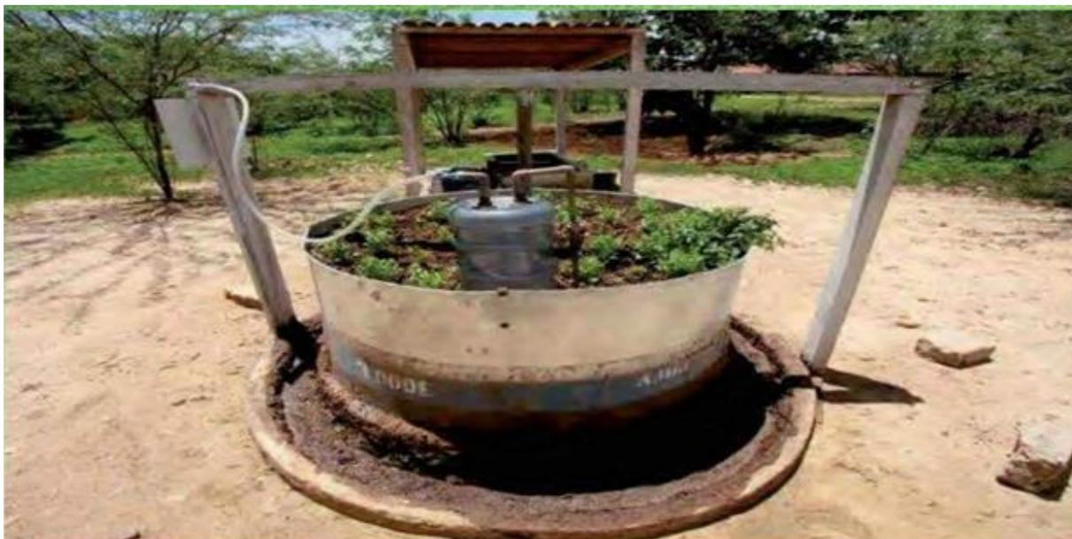
**Figura 1.** Biodigestor sertanejo construído no nordeste brasileiro. Fonte: Mattos, L. C., & Farias, M. J. (2011). Manual do biodigestor sertanejo. Projeto Dom Helder Camara. 55p. Recuperado de <http://www.diaconia.org.br/novosite/biblioteca/int.php?id=53>
