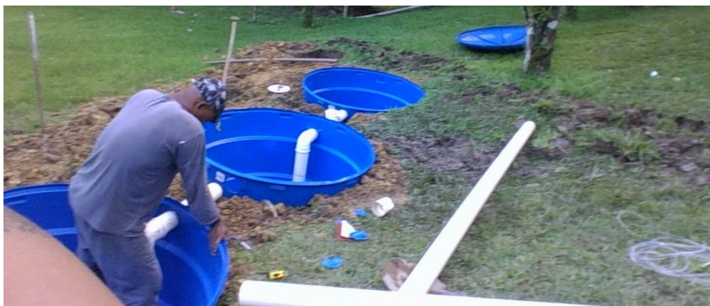
Figura 4: Projeto de fossa biodigestora na propriedade 02, executado em Abril de 2017.
