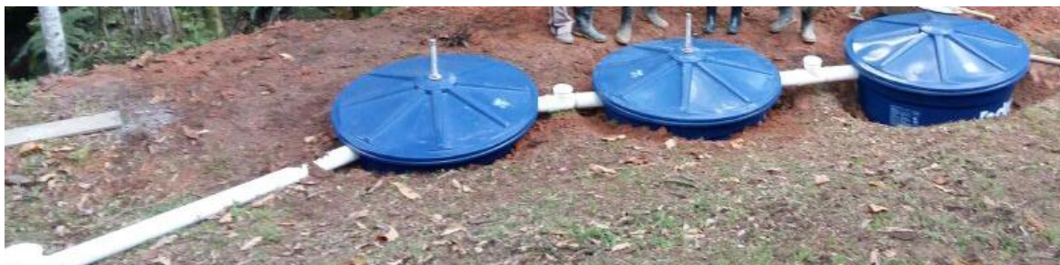
Figura 3: Projeto de fossa biodigestora na propriedade 01, executado em Março de 2017.
