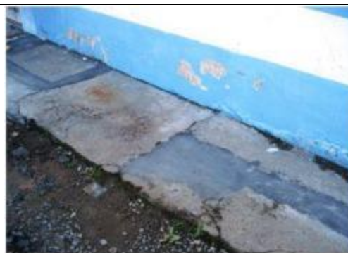
Foto 25: Vazamento de esgoto consertado
