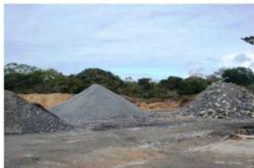
Foto 13: Material acumulado em área anexa ao canteiro
