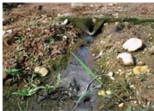
Foto 23: Vazamento de esgoto
