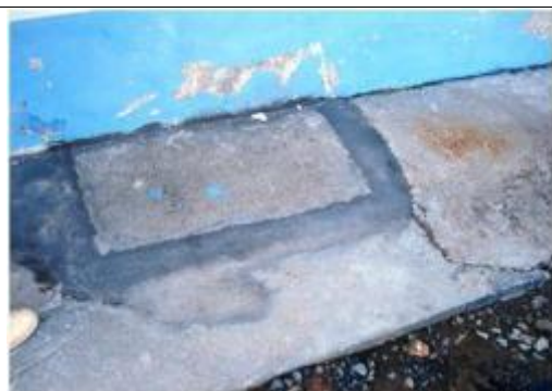
Foto 24: Vazamento de esgoto consertado
