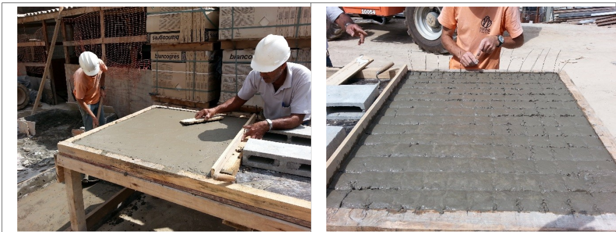
Figura 5 - Processo de produção do espaçador seguindo as instruções da Patente US4147008 no canteiro de obras (Créditos das fotos: João Henrique Stoporoli - 2014)
