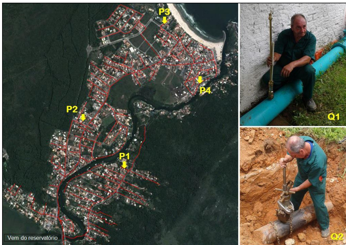
Figura 4. Pontos de monitoramento de pressão (P1, P2, P3, P4) e detalhes da instalação dos tubos de Pitot na saída do booster (Q1) e na saída do reservatório (Q2)
